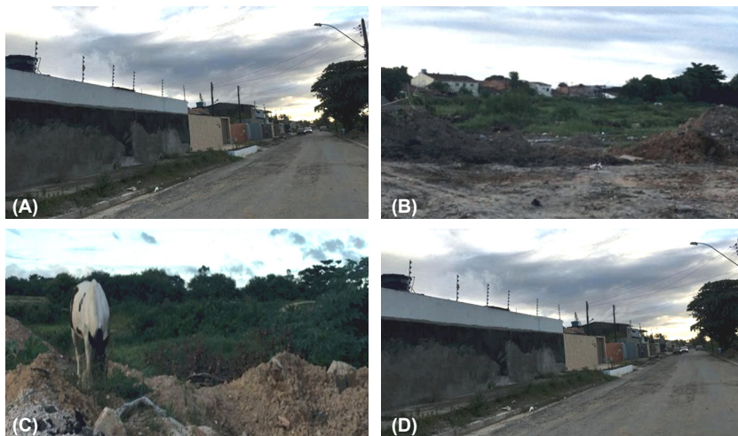
Figura 2 - Uso e ocupação do solo no bairro da Santa Lúcia.
